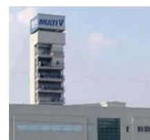
Testy długości instalacji
